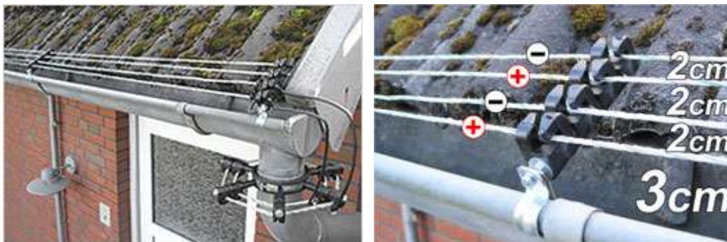
Figuur 11 - Draden onder elektrische spanning om te vermijden dat steenmarters onder het dak kruipen (foto's: www.weidezaun.info )
